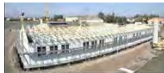
DOPO 15 GIORNI IL TETTO E' MONTATO
