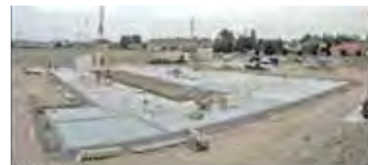
POSA PRIMA PARETE
